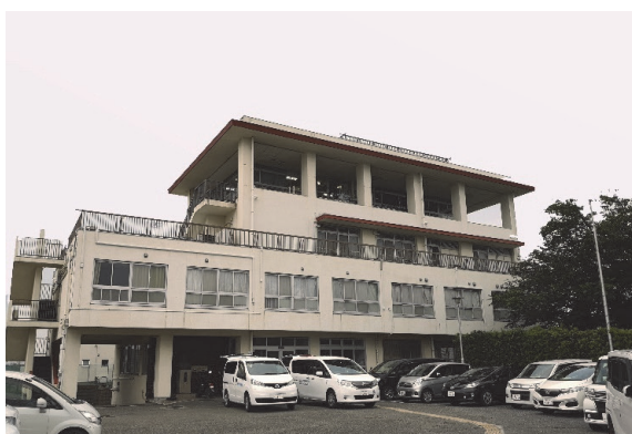
三浦市総合福祉センター グループホームの外観
