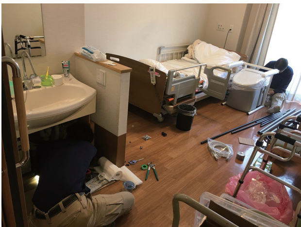
設置工事の様子
